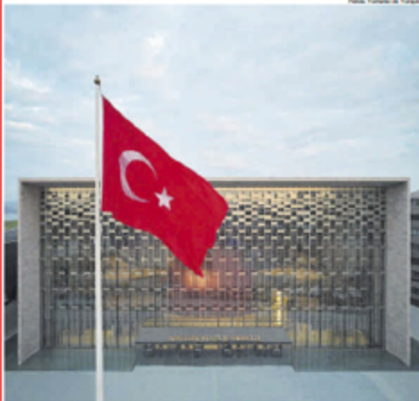
La fachada principal vista desde la plaza Taksim, uno de los emblemas de la capital turca.
